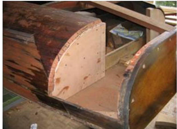
Het geplaatste tussenspannt waarop we de nieuwe latten kunnen bevestigen
